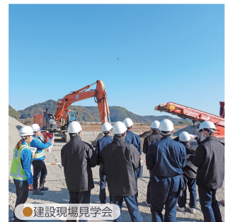
●建設現場見学会
